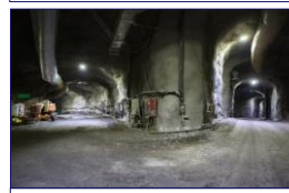
De bouw van een testtunnel
