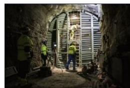
De aanleg van een tunnelstelsel
