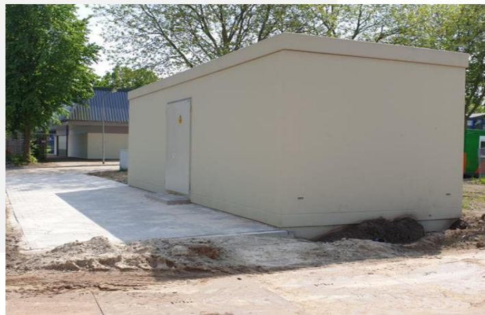
Afbeelding: schakelstation in Borger
