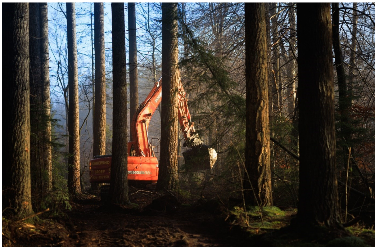
Oude sloten en rabatten worden gedempt voor hydrologisch herstel van het bosgebied.
