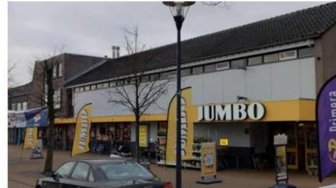
Gevel oude situatie
