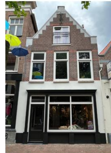
Gevel na realisatie gevelverbetering (met subsidie)
