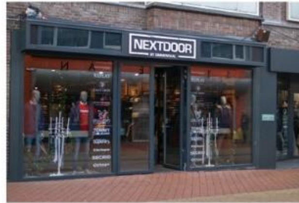
Gevel oude situatie
