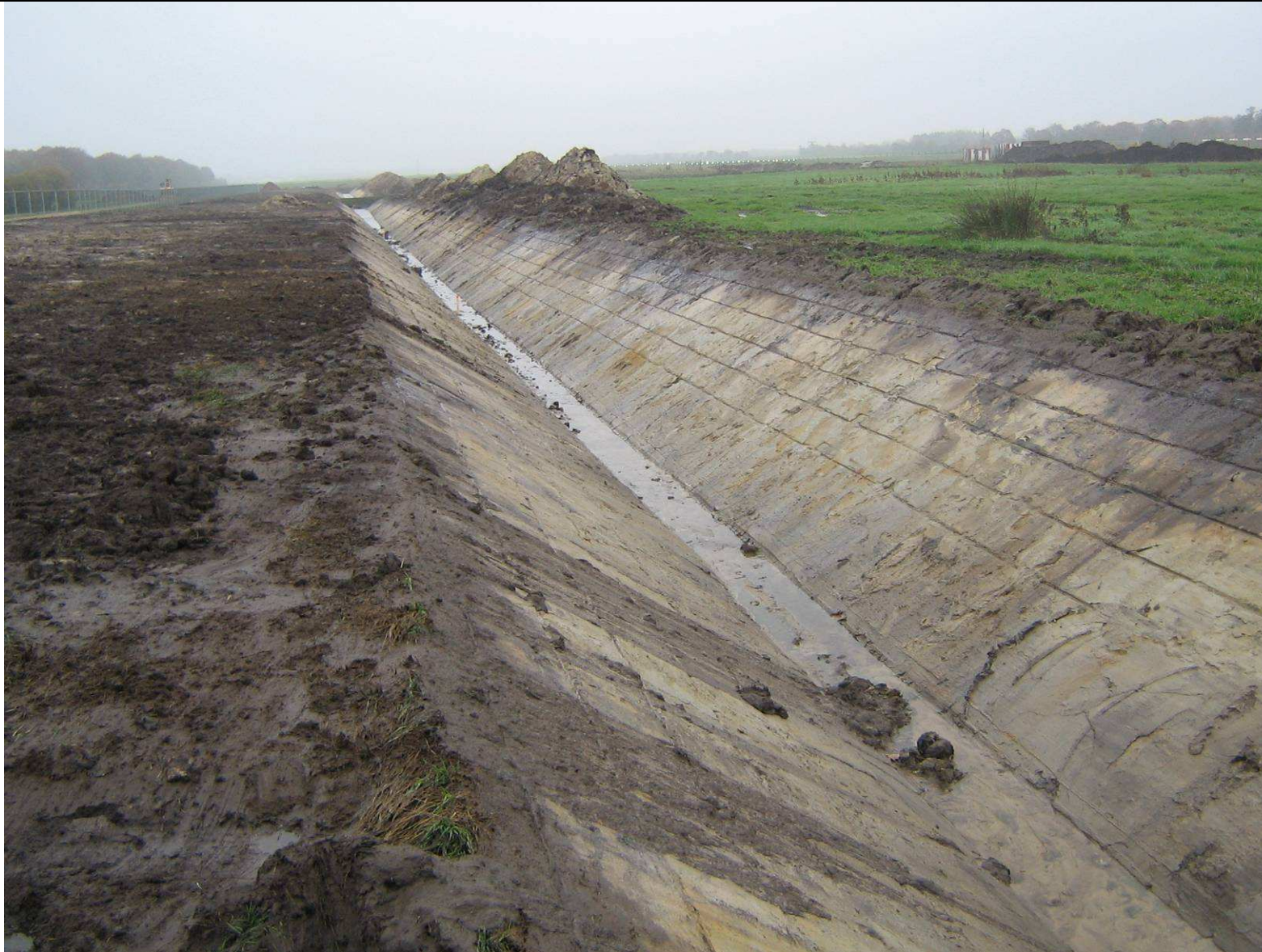
Foto 1, Noordelijke afwateringssloot langs baanverlenging opname 13 nov 2012. pand A, 3
