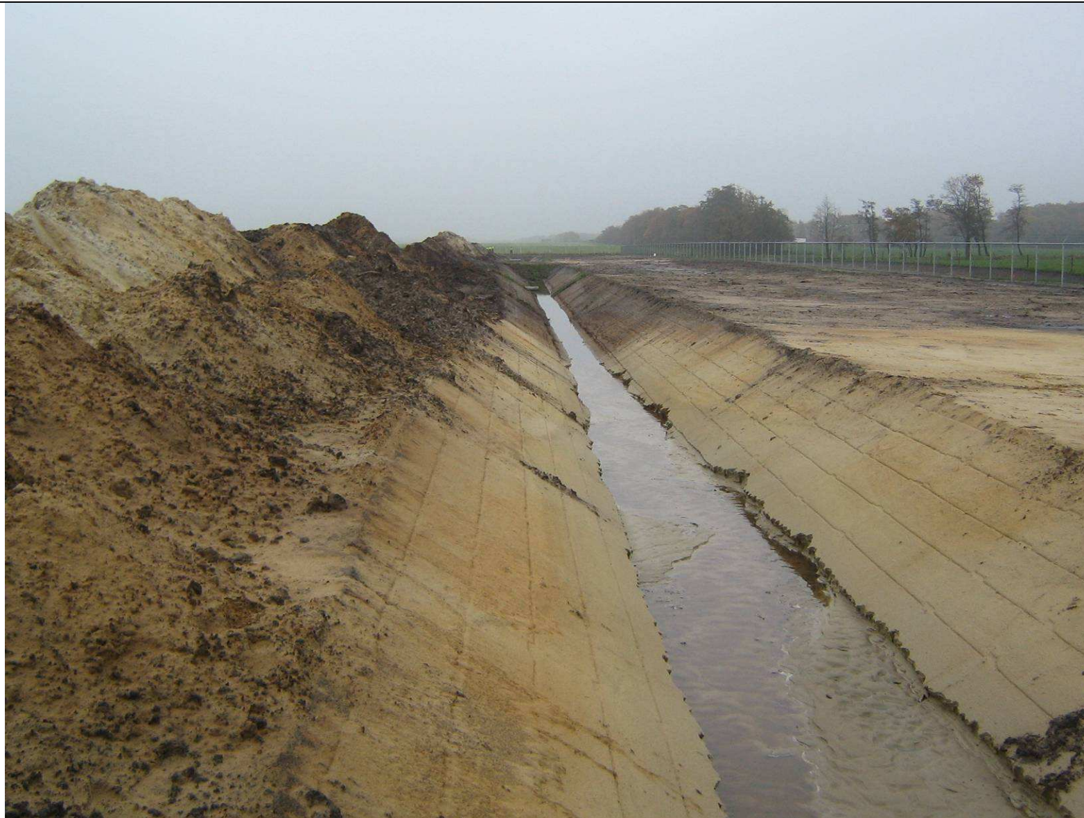
Foto 7, 13 november 2012 Zuidelijke afwateringssloot B, pand 2
