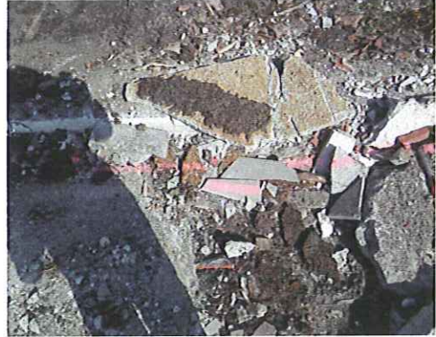
Foto 12. Vlakke plaat in beton (Abm/501),
