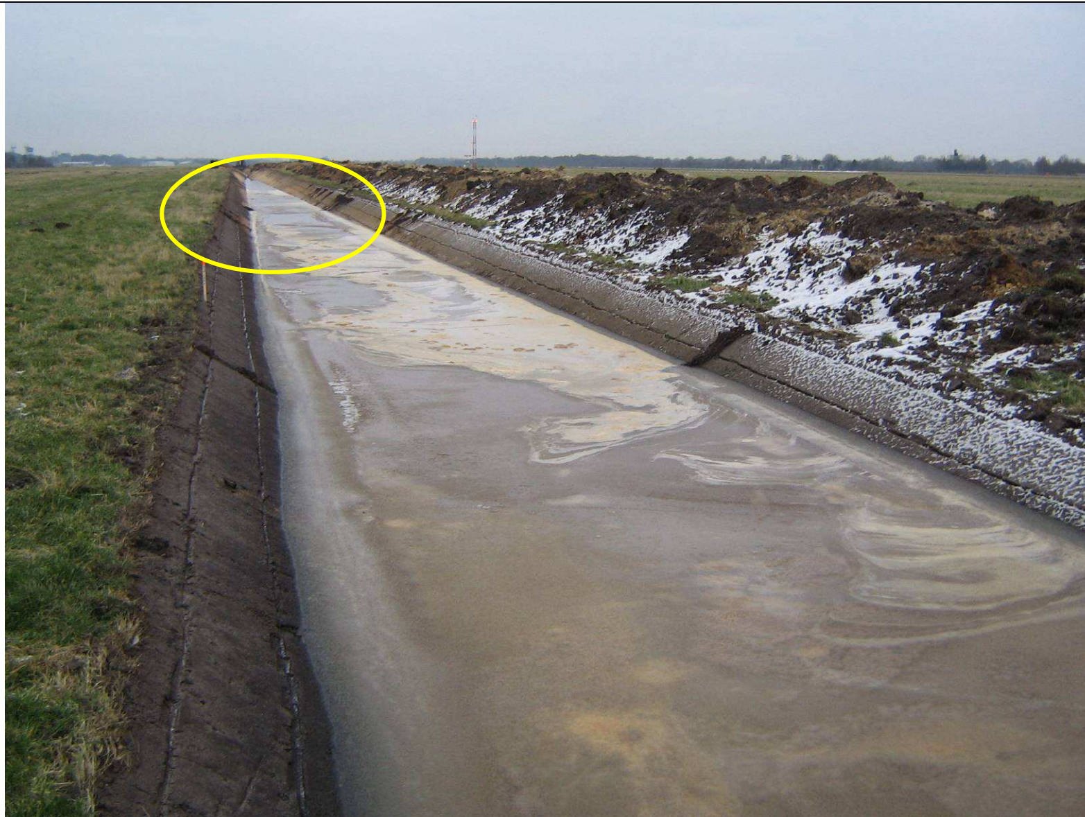
Foto 2; Beekdal Runsloot Oost, Sectie C, Pand 2 (tussen start- en taxibaan)
