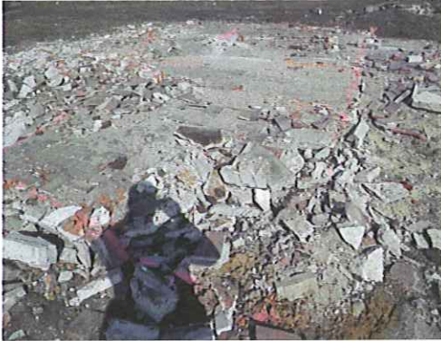
Foto 9. Vlakke plaat in beton (Abm/501),
