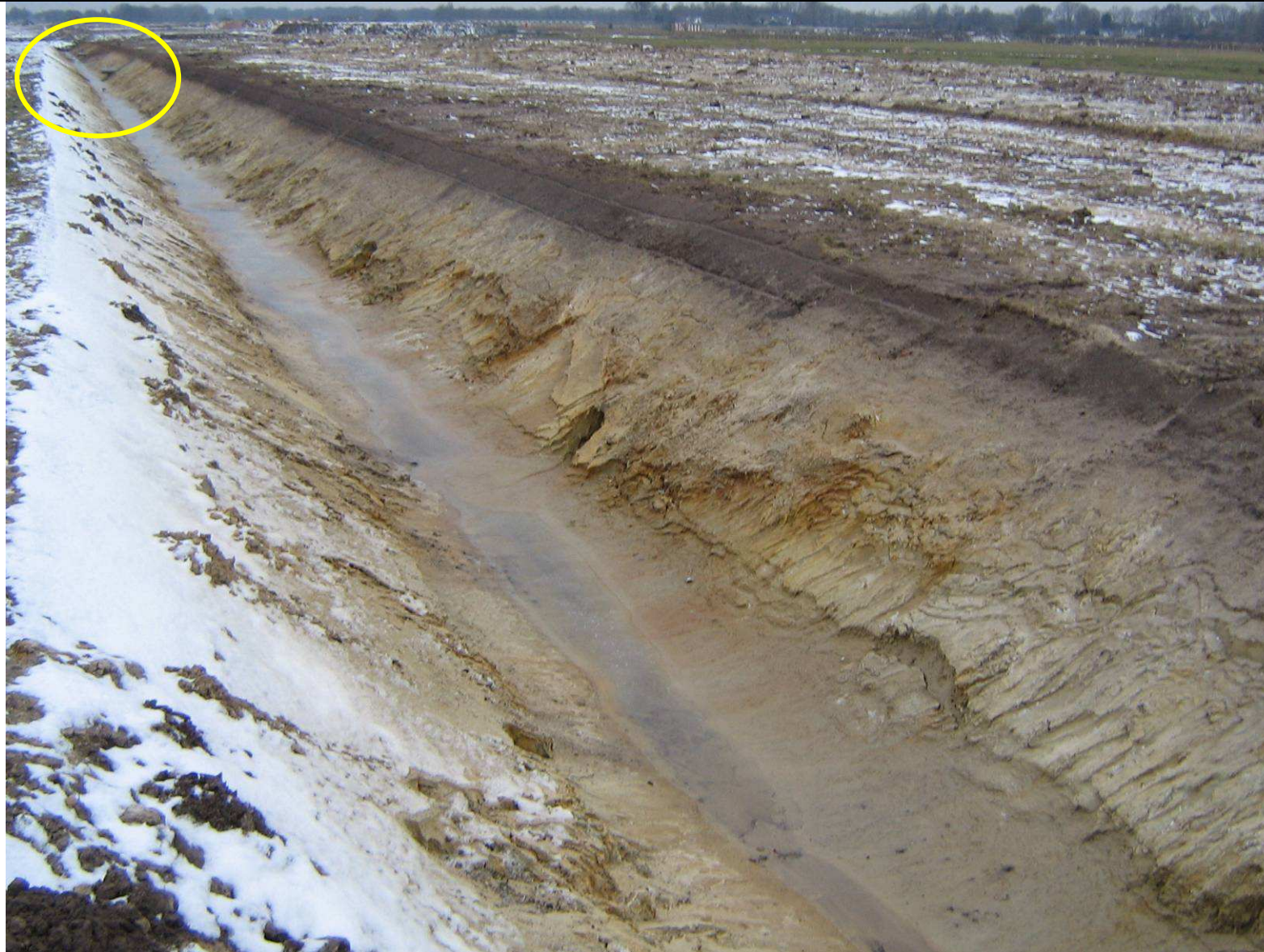
Foto 14 ; Beekdal Runslot Oost, Sectie D, Pand 1
