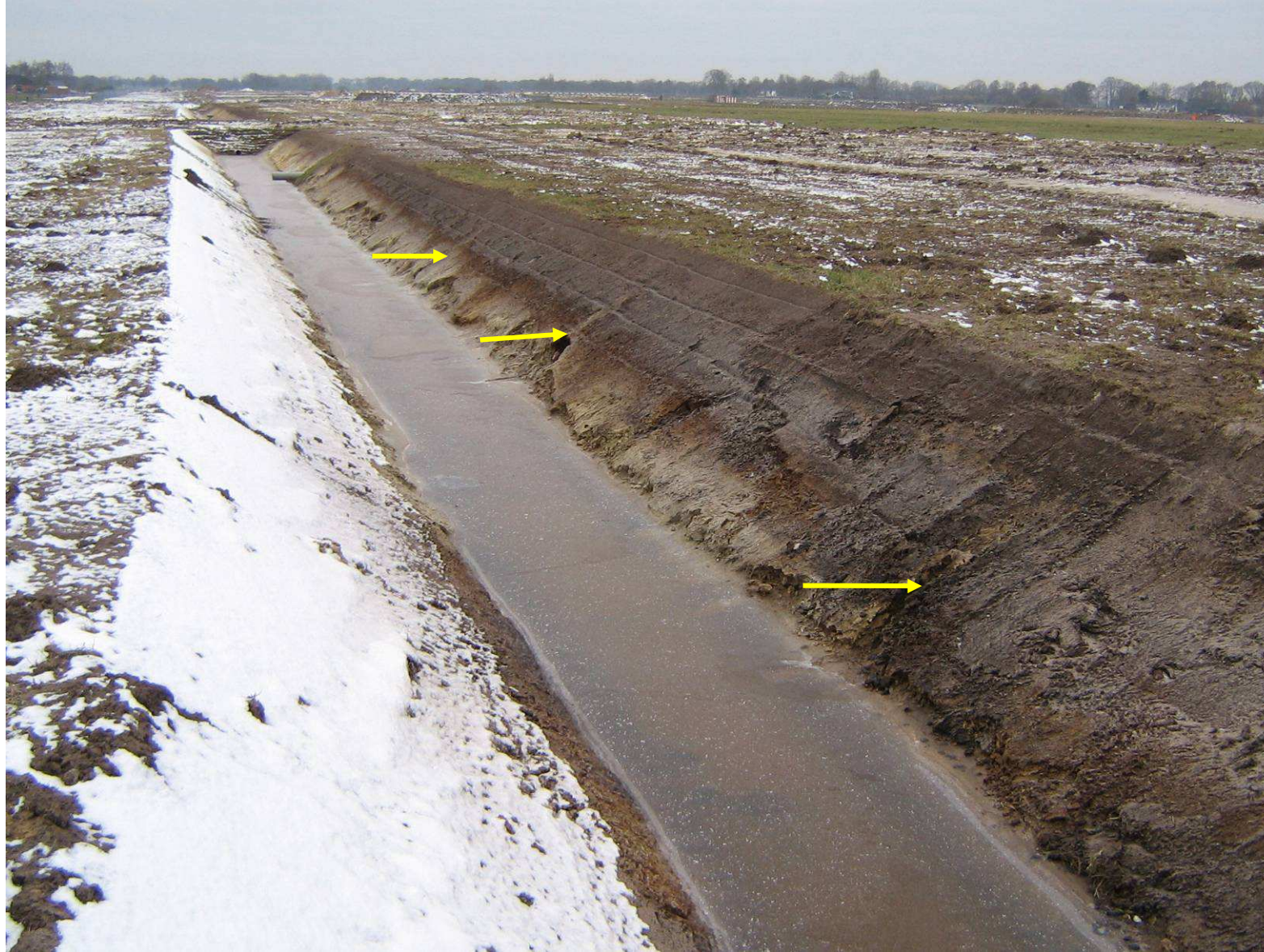
Foto 11 ; Beekdal Runsloot Oost, Sectie D, Pand 2
