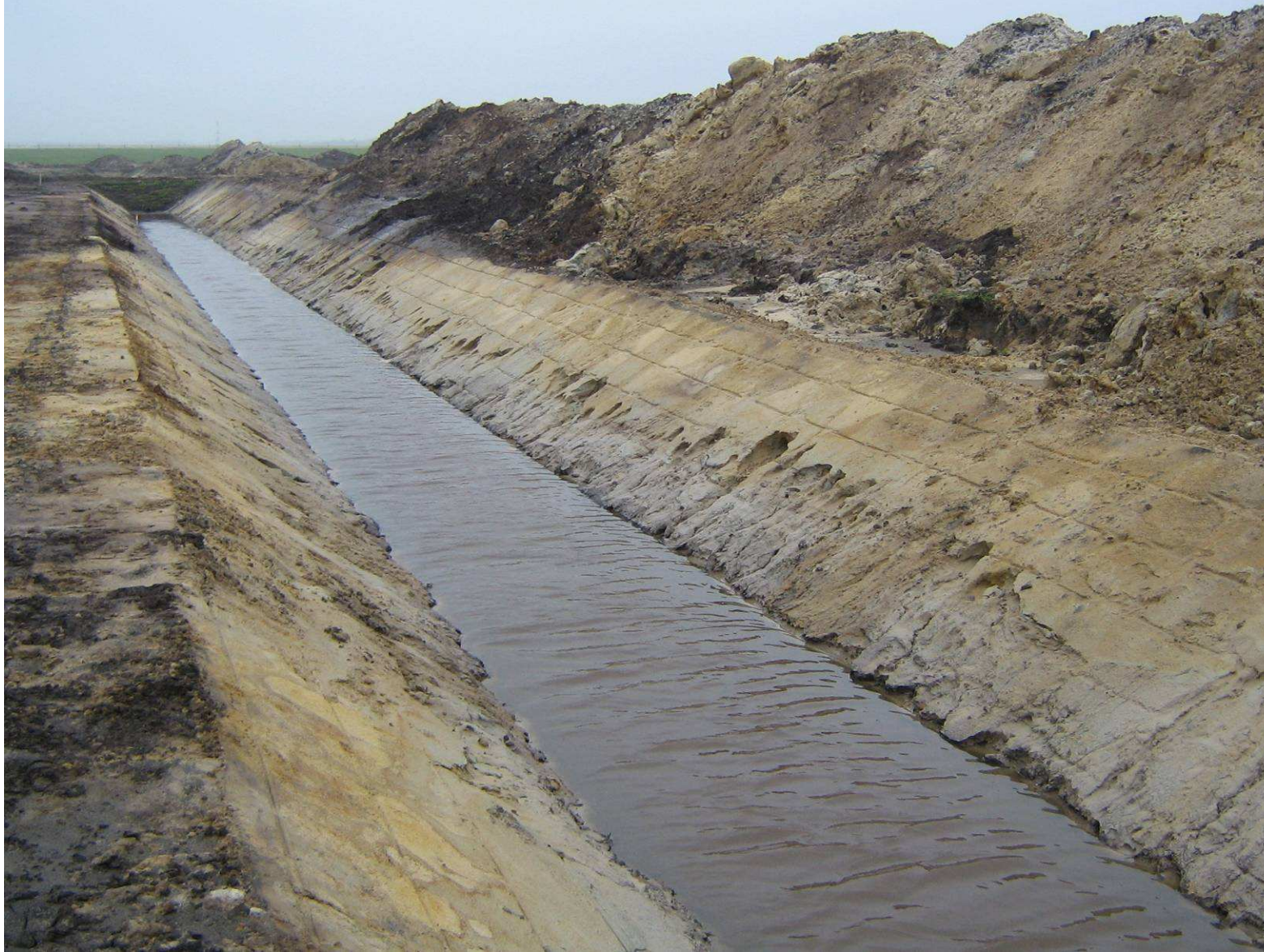
Foto 3 , 13 nov 2012, noordelijke afwateringssloot parallel aan baanverlenging; pand A, 2
