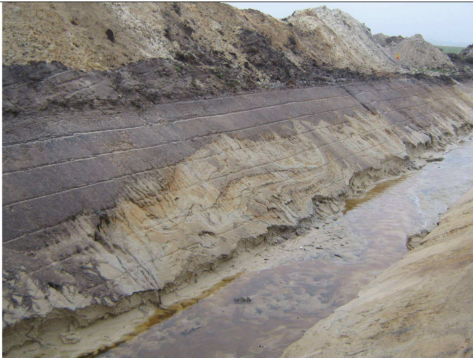
Foto 9-a stuwing in ondergrond, pand B,1
