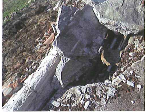
Foto 10. Vlakke plaat in beton (Abm/501),
