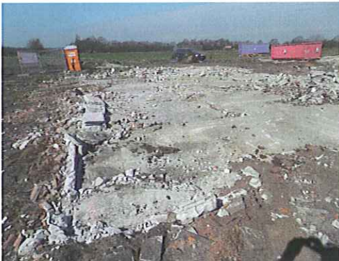
Foto 13. Vlakke plaat in beton (Abm/501),
