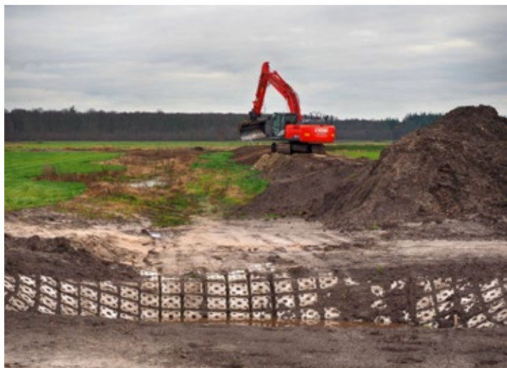
WERKEN AAN DE DUKKER ONDER DE OUDE WILLEMSWEG EN DE SLENK.
