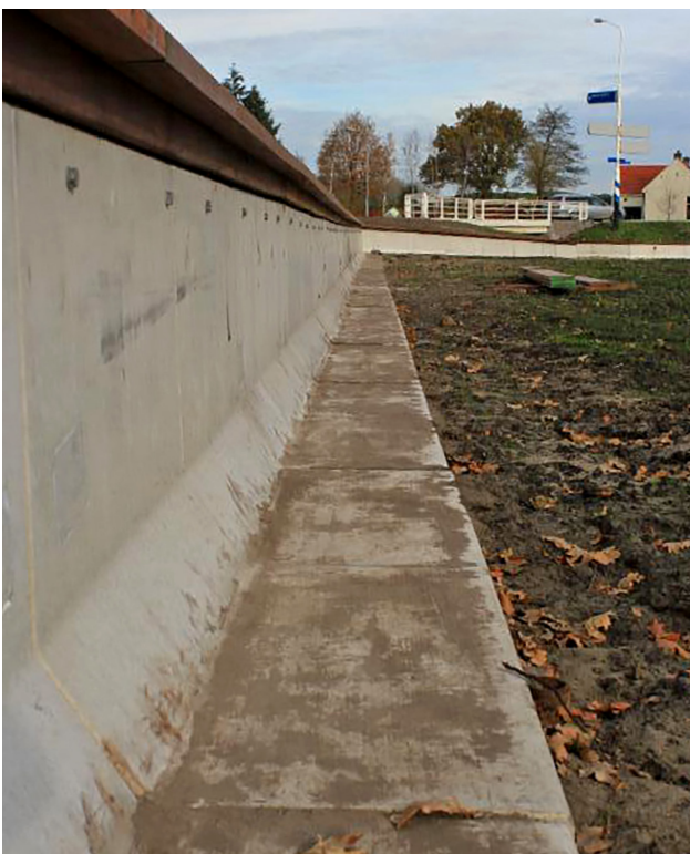
Figuur bijlage 1: Twee voorbeelden van geschikte betonnen schermen. Beide hebben aan de bovenzijde een overstekende rand om te voorkomen dat dieren over de rand kunnen klimmen en aan de voet een horizontale rand om de groei van vegetatie te voorkomen en onderhoud te vereenvoudigen (Foto's: Richard Struijk (links, Veenhuizen) en Maibach GmbH (rechts)).
