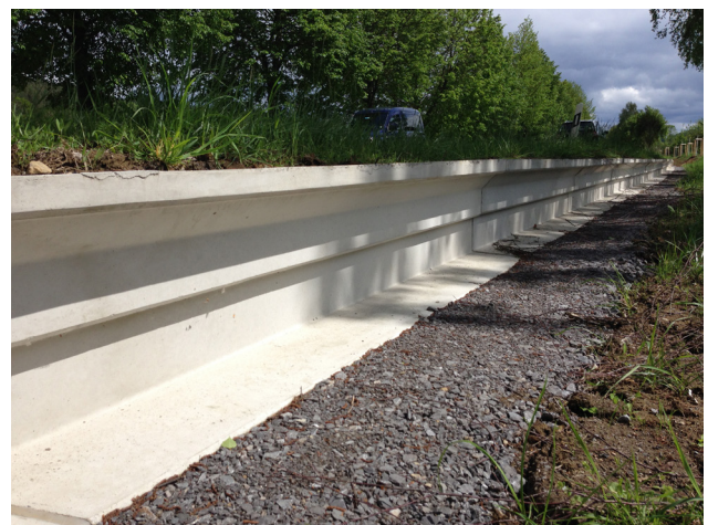
Figuur bijlage 1: Twee voorbeelden van geschikte betonnen schermen. Beide hebben aan de bovenzijde een overstekende rand om te voorkomen dat dieren over de rand kunnen klimmen en aan de voet een horizontale rand om de groei van vegetatie te voorkomen en onderhoud te vereenvoudigen (Foto's: Richard Struijk (links, Veenhuizen) en Maibach GmbH (rechts)).
